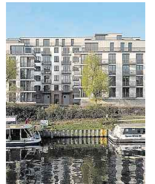
Historische Substanz, moderner Neubau. Direkt an der Spree, nahe dem Schloss Charlottenburg, realisierte das Büro „Collignon-Architektur“ für die H'Group, SpreeLofts GmbH (München) 57 Etagenlofts, Townhouses und Penthouses. Die zwei langjährig brachliegenden Fabrikgebäude der ehemaligen Heliowatt-Werke von 1907 und 1925 am Charlottenburger Ufer wurden revitalisiert, erweitert und zu hochwertigen Loft-Wohnheiten mit zirka 7000 qm Wohnfläche umgenutzt.
